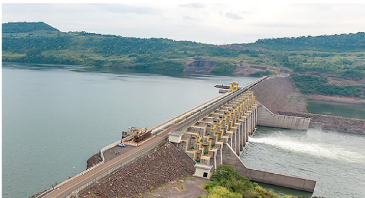
Figura 4 - Usina Hidrelétrica Foz do Chapecó
